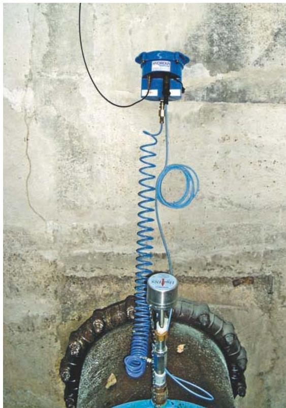
Équipés en standard d'une prise de pression, les débitmètres HydrINS 2 d'Hydreka, associés aux loggers de sectorisation LX avec renvois SMS vers la télégestion, constituent un outil de sectorisation débit/pression intéressant pour les exploitants de réseaux.
