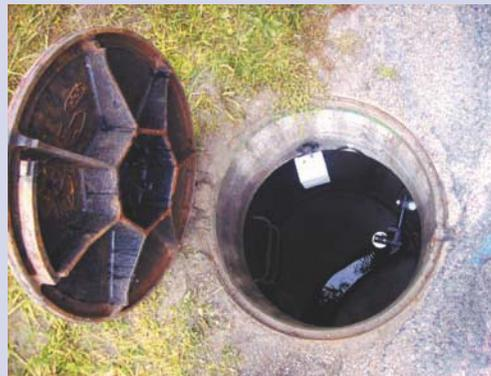
**WATA, le système de capteurs à ultrasons développé par Sirea Environnement est adapté à la surveillance permanente des débits dans les réseaux d'assainissement : zone de mesure très étroite, distance de mesure jusqu'à 3 m, étanchéité IP68.**
