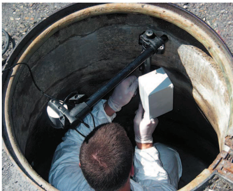
Figure 6 : Mise en place par le technicien.
