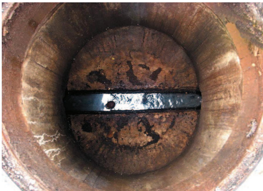
Figure 2 : Cunette vue du haut d'un regard.
